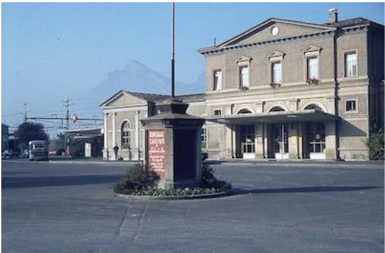
Bild 4: SBB Bahnhof Bad Ragaz, Aufnahme von 1975
